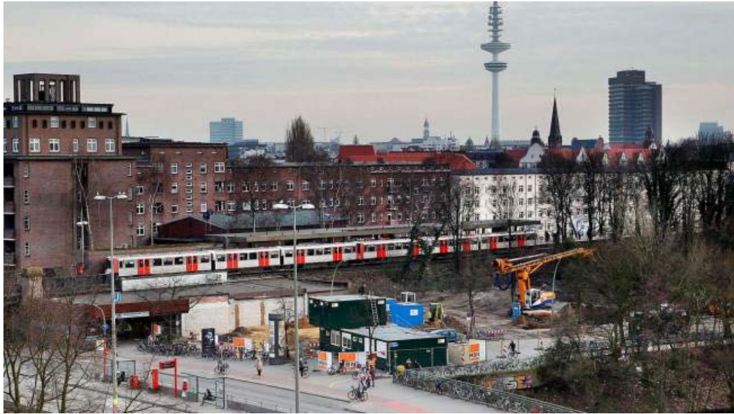
Abbildung 2: Beginn der Bauarbeiten 2
