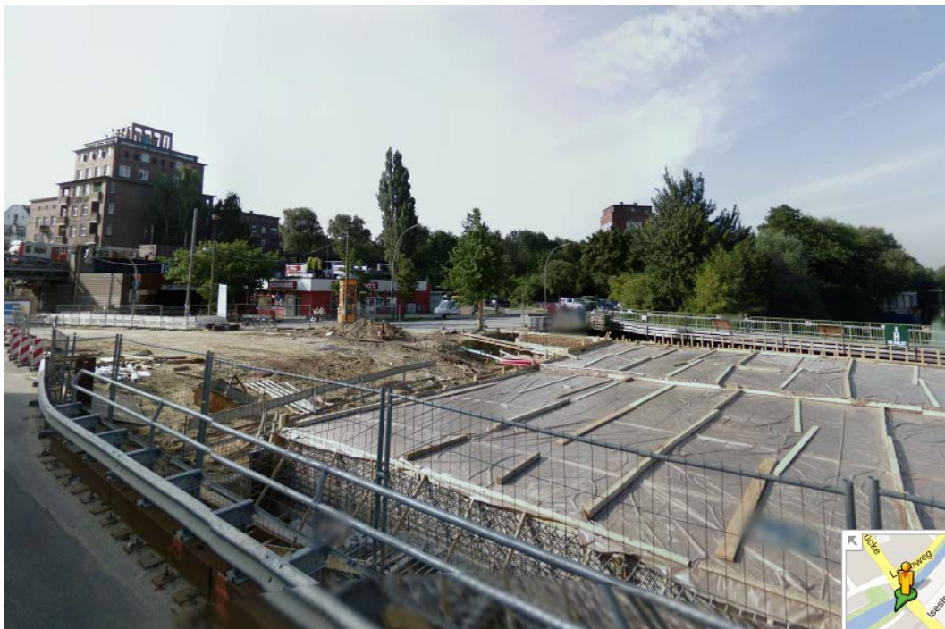
Abbildung 1: Vor dem Bauvorhaben 1
